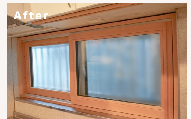
木製内窓を設置
